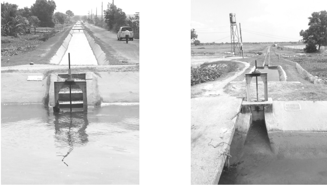
Hình 3: Kênh và cống đầu kênh cấp 2 và 3 của hệ thống kênh TN17-5
