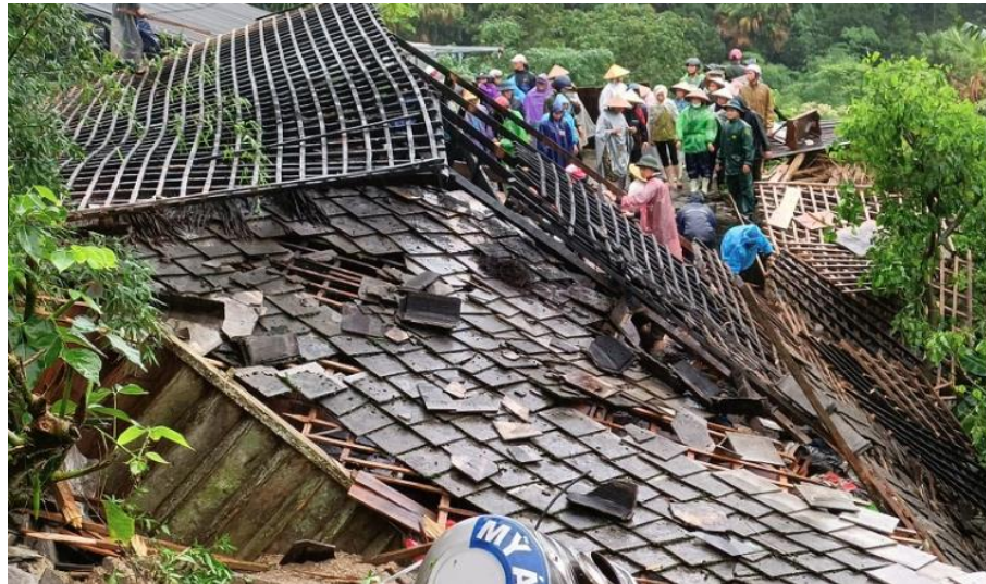
Nhà sập tại Vị Xuyên, Hà Giang
