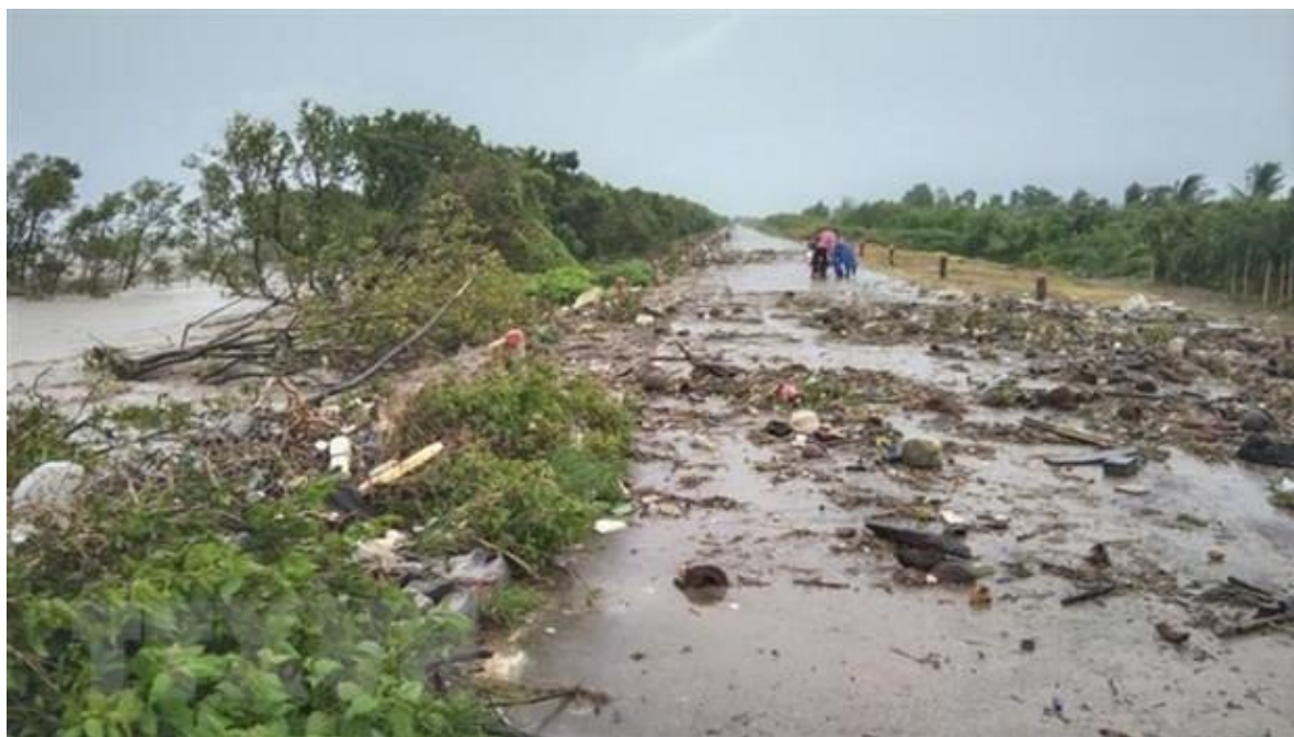
Sạt lở đê biển Tây thuộc khu vực xã Khánh Bình Tây, huyện Trần Văn Thời
