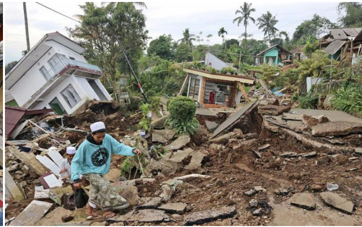
Nhà cửa bị phá hủy do động đất
