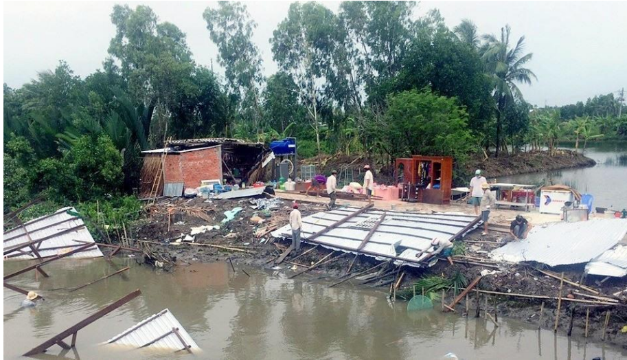
Mưa lớn kèm theo dông lốc đã làm sập và tốc mái hàng trăm căn nhà trên địa bàn huyện Trần Văn Thời khiến nhiều người mất nhà cửa
